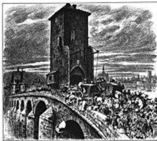
La Catastrophe du 11 octobre 1711 au pont de Guillotière.
